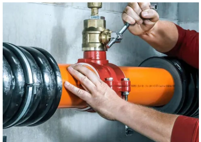
Das Anbohren der PE-Xa Leitungen unter Druck ermöglicht den nachträglichen Netzausbau ohne Einschränkungen im Betrieb.
