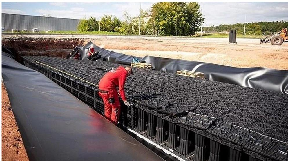
ACO bietet eine breite Palette von Systemen für die **Infrastruktur** an, darunter Lösungen für die Versickerung von Regenwasser, Wasserreinigungssysteme und Drosselschächte. Alle ACO-Systeme erfüllen die Normen DWA-A 102 und DWA-A 138.
