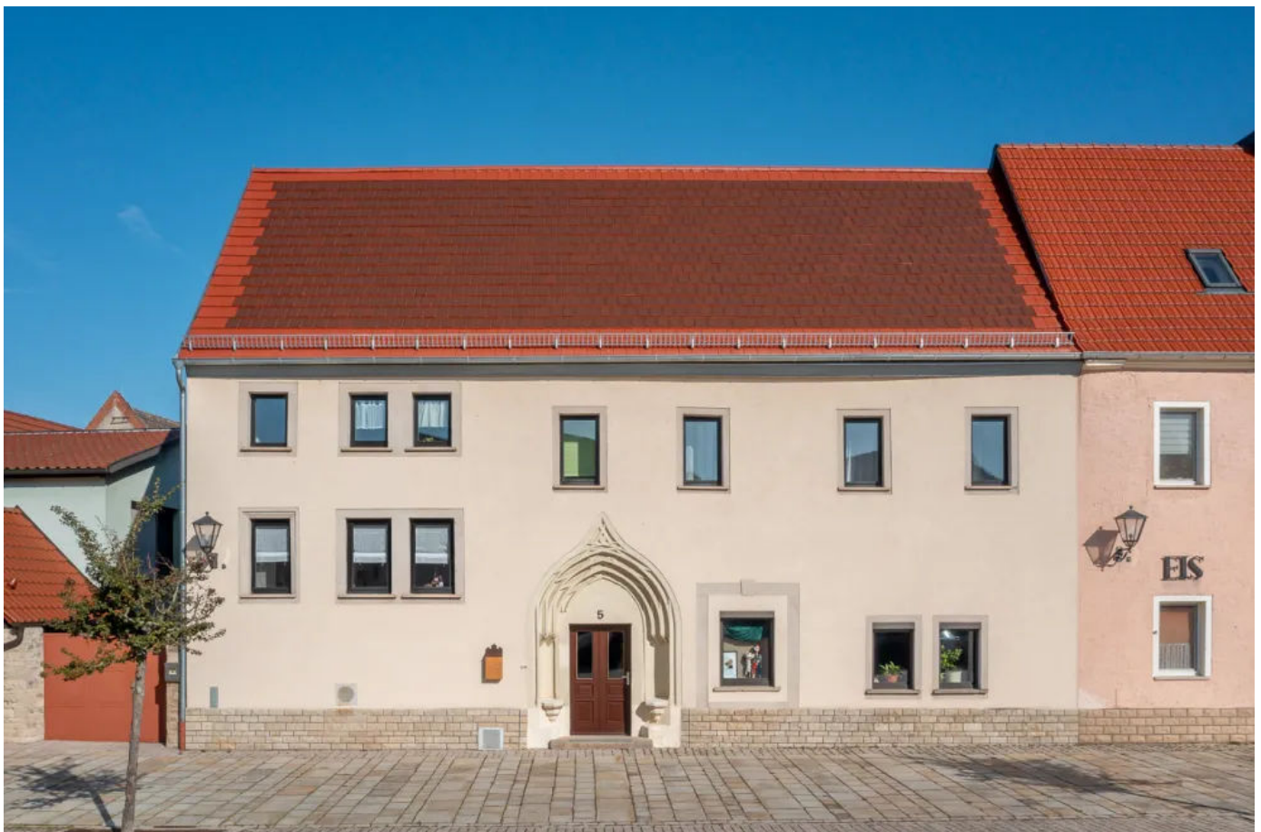
Historisches Wohnhaus im Stadtkern von Nebra: Planung ADOBE Architekten + Ingenieure GmbH (Erfurt) und Ausführung Dachdeckerfachbetrieb Fehse GmbH (Lützower Str. 17, 06642 Memleben) © Susanne Buchholz
