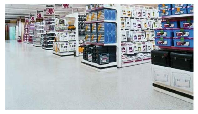
Epoxidharzbeschichtung, Polyurethanharzbeschichtung, Mattierungsfinish SE
