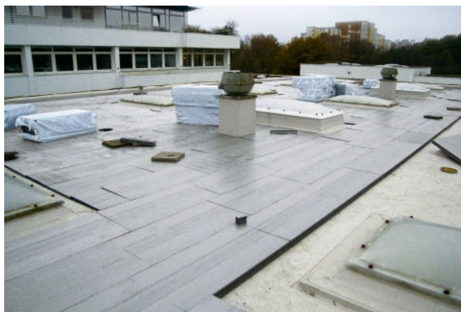
RAVATHERM™ XPS X 300 SL Platten werden im Verband verlegt, die Anschlüsse an Lichtkuppeln sind exakt anzuarbeiten
