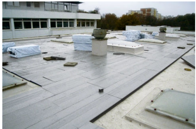
RAVATHERM TM XPS X 300 SL Platten werden im Verband verlegt, die Anschlüsse an Lichtkuppeln sind exakt anzuarbeiten
