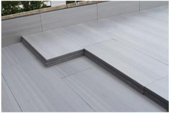
1.500 m² Wandfläche und weiteren 2.600 m² für ein begrüntes Umkehrdach eingesetzt. Dank einer Zustimmung im Einzelfall der Obersten Baubehörde im Bayerischen Staatsministerium des Inneren durften RAVATHERM™ XPS X 300 SL Platten in Verbindung mit der wasserableitenden Trennlage ROOFMATE™ MK auf dem als Dachgarten geplanten Umkehrdach doppellagig mit einer Gesamtdicke von 220 mm verlegt werden.
