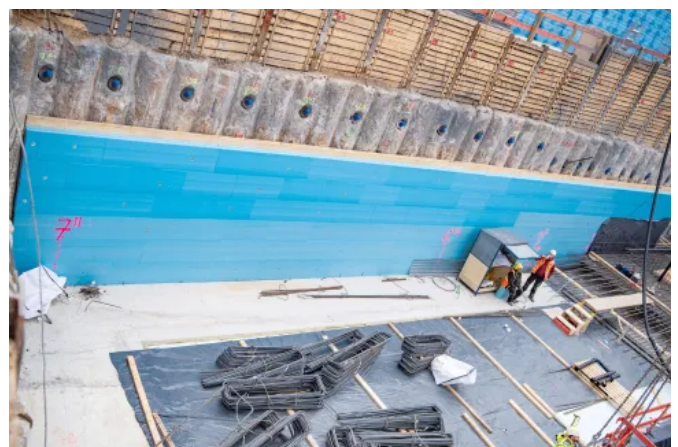
Dämmung von Kelleraußenwänden mit RAVATHERM XPS 300 SL
