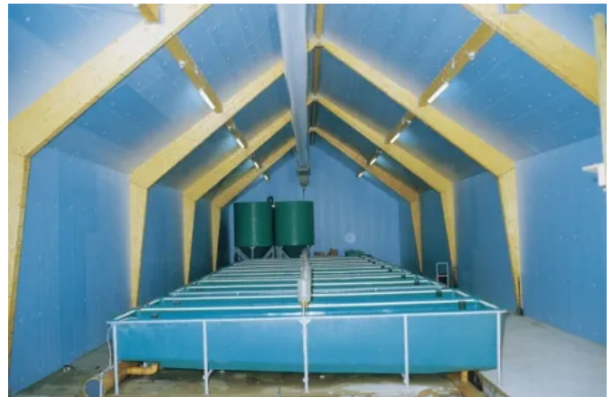
Dämmung eines Beckens für Fischzucht
