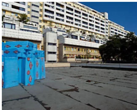
Verlegebeispiel in der Praxis: Hier wurde bereits eine neue Abdichtungslage aufgebracht.
