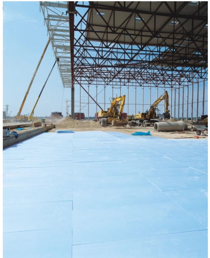
Wärmedämmung oberhalb der Bodenplatte
