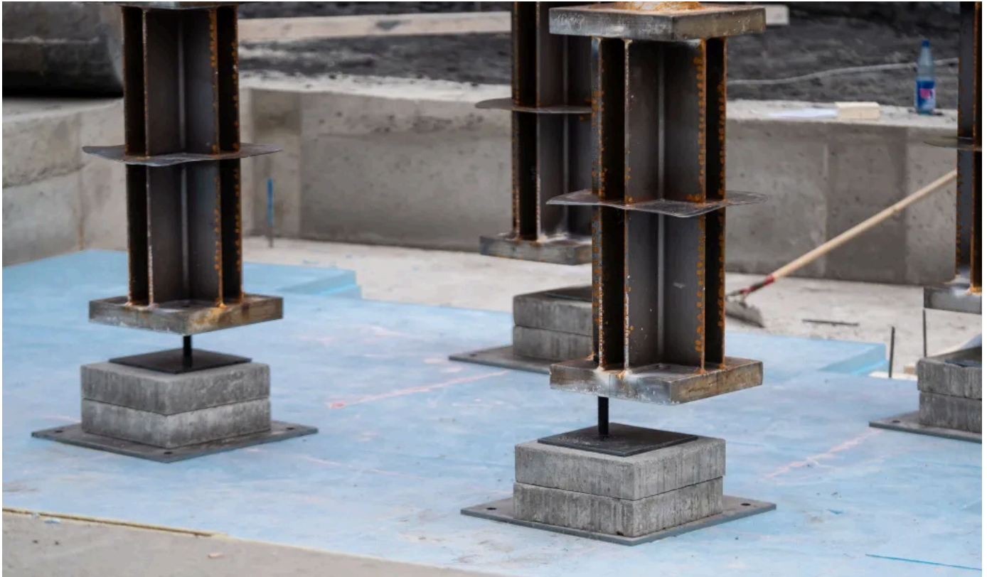
RAVATHERM XPS 700 SL zur Dämmung unter der Bodenplatte
