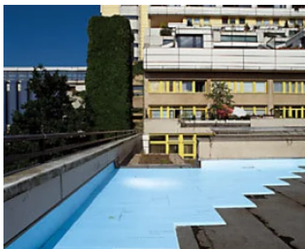
Darauf werden die RAVATHERM™ Dämmplatten lose und im Verband verlegt.
