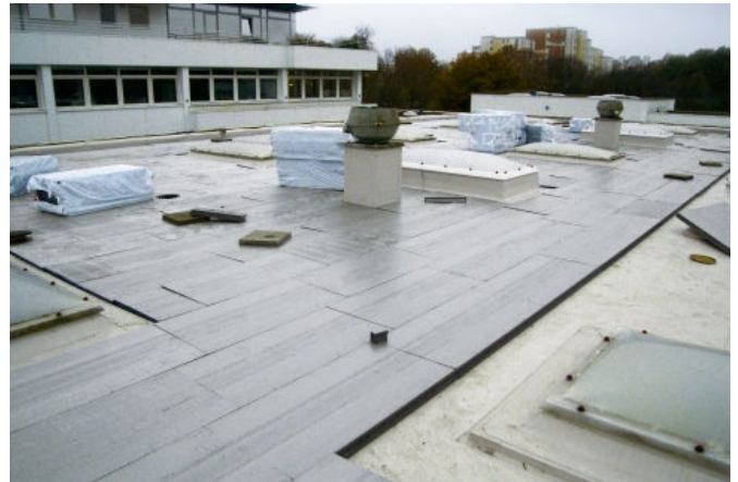
RAVATHERM™ XPS X 300 SL Platten werden im Verband verlegt, die Anschlüsse an Lichtkuppeln sind exakt anzuarbeiten
