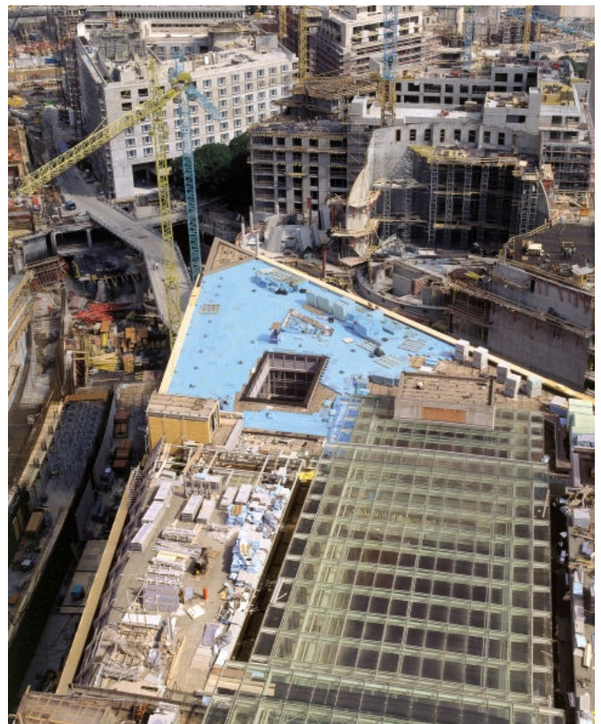
Am Potsdamer Platz, Berlin, wurden über 100.000 m 2 Dachflächen als Umkehrdächer (bekiest, begrünt, befahrbar) ausgeführt.
