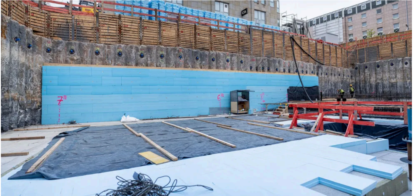
RAVATHERM XPS 700 SL in einer Stärke von bis zu 120 mm gemäß Bauartgenehmigung für den Einsatz unter der Gründungsplatte zulässig.
