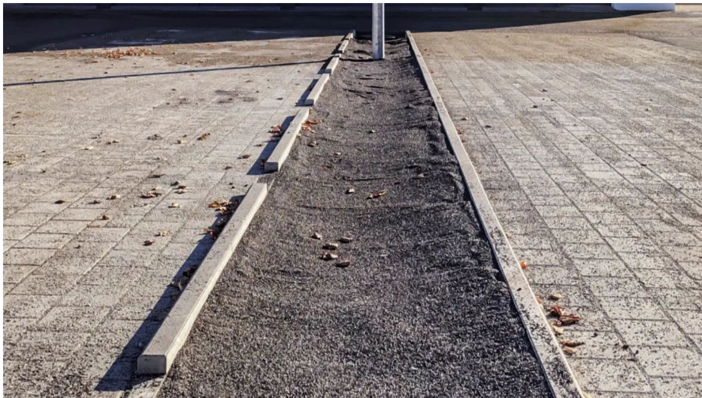
RAUSIKKO PURAT 200 Filtersubstrat zur Reinigung von verschmutztem Niederschlagswasser
