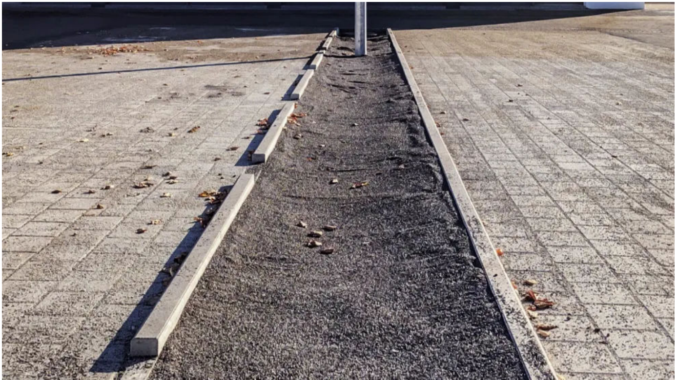
RAUSIKKO PURAT 200 Filtersubstrat zur Reinigung von verschmutztem Niederschlagswasser
