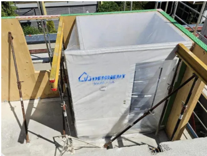
Vorgefertigte Badmodule für serielle Bauvorhaben
