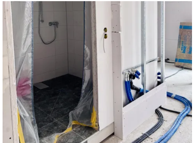
Vorgefertigte Badmodule für serielle Bauvorhaben
