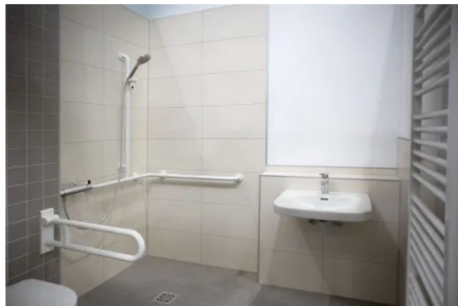
Vorgefertigte Badmodule für serielle Bauvorhaben
