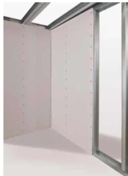
Beplankung eines Raumsystems
