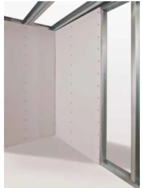
Beplankung eines Raumsystems
