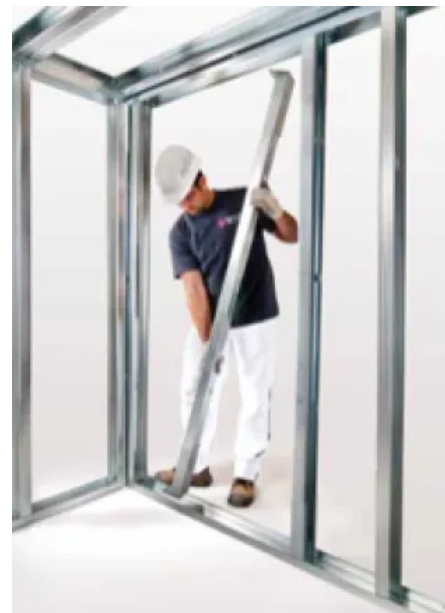
Tragwerk eines Raumsystems
