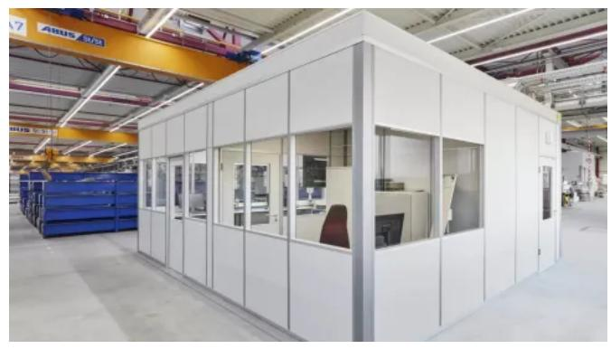
Ausführung basiert auf dem Trennwandsystem PANEasy mit deckenintegrierter Lüftung und Beleuchtung
