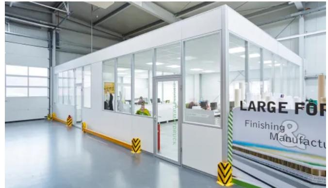
Ausführung basiert auf dem Trennwandsystem PANframe mit deckenintegrierter Lüftung und Beleuchtung
