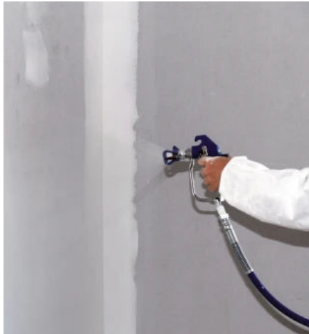
Der effiziente Kleisterauftrag erfolgt mit dem Airless-Gerät.
