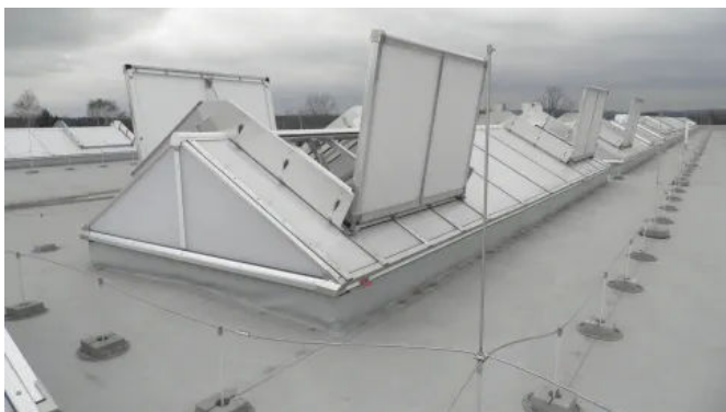
LAMILUX Rauchlift Lichtband S SILON in Sezimovo Ústí, Tschechien
