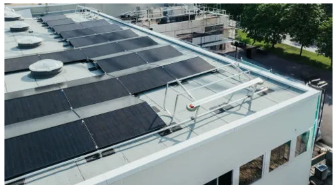
Das einklappbare Geländer erzeugt keinen permanenten Schatten auf den Solar-Modulen, was die Effizienz der Photovoltaikanlage erhöht.
