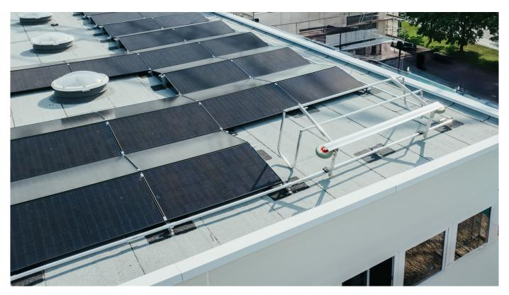
PV-Systeme mit integrierter Absturzsicherung bieten Sicherheit und Energieeffizienz. Die Kombination aus stabilen Photovoltaik-Unterkonstruktionen und mobilen Geländersystemen zur Absturzsicherung ermöglicht verschattungsoptimierte PV-Lösungen und sichere Wartungswege in Einem. Die PV-Systeme mit integrierter Absturzsicherung von ABS Safety sind bis zu 90% leichter als herkömmliche Kombinationen.
