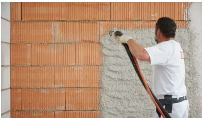
Gips-Maschinenputze für ein angenehmes Raumklima
