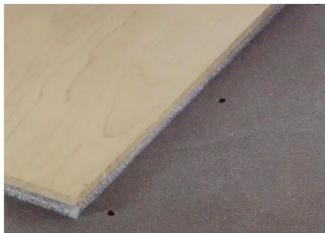
... Löcher mit Hilfe der zugeschnittenen Rampe vorbohren ...
