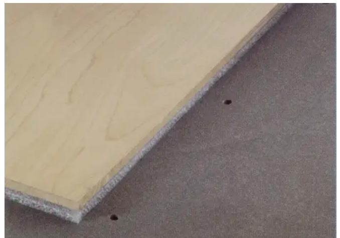
... Löcher mit Hilfe der zugeschnittenen Rampe vorbohren ...
