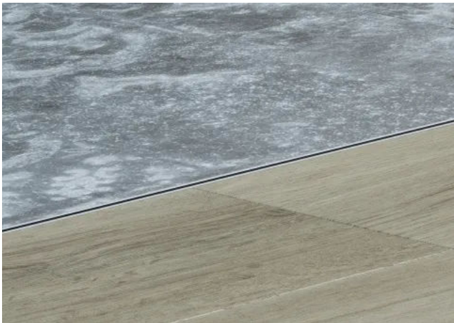
Dehnfugenprofil 302S im Detail
