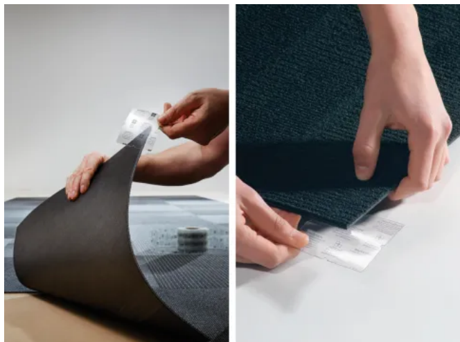
Verlegung mit TacTiles®
