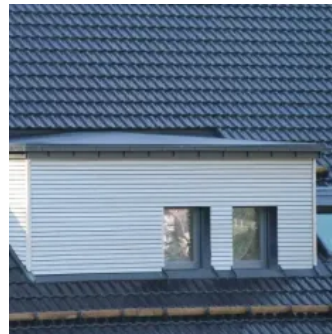
Abdichtung von Gauben
