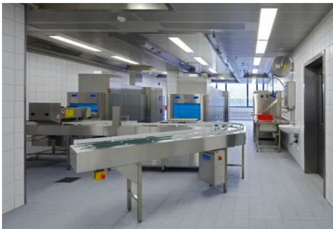
Zuverlässige Innenraumabdichtung für hoch belastete Bereiche mit WOLFEN
