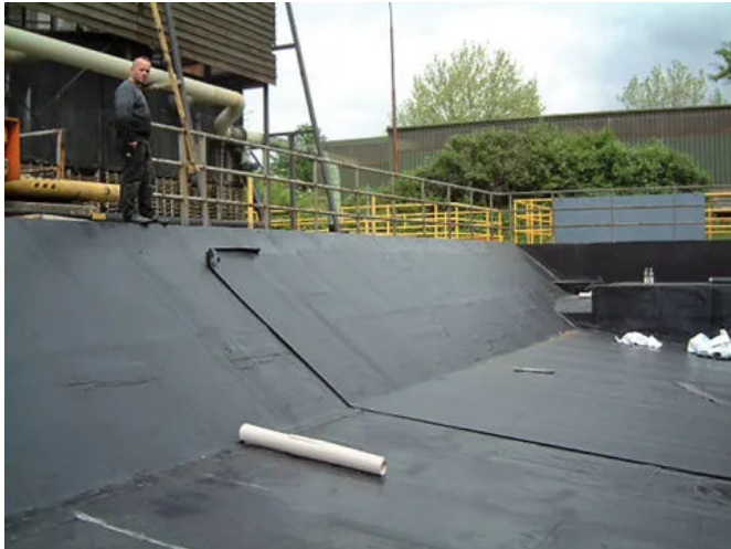
Zuverlässiger Rückhalt wassergefährdender Flüssigkeiten in LAU-Anlagen durch die DIBt-geprüfte WOLFEN IB Abdichtung
