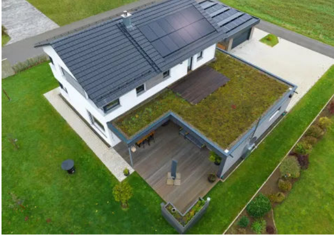
Gründach privates Einfamilienhaus in Süddeutschland
