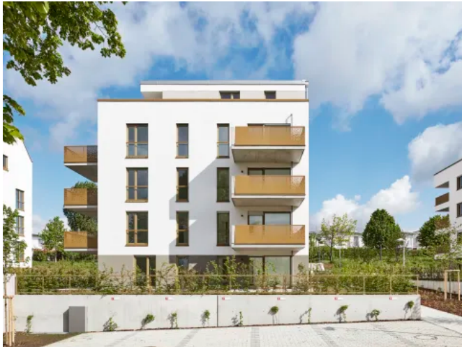
Wohnanlage Ludwigsburg: Außenwände aus Poroton-Ziegeln S9 und Poroton-WDF 12 cm in Teilbereichen vor aussteifenden Betonwänden erfüllen Statik, Wärmeschutz und wohngesundes Raumklima. (© Fotografie Dietmar Strauß)
