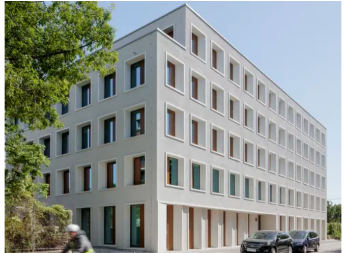
Unionshilfswerk Berlin: Durch die Ergänzung der Außenwände mit Poroton-WDF entstand ein 59 Zentimeter dicker, quasi monolithischer Wandaufbau mit einem U-Wert von 0,15 W(m 2 K). (© Ulrich Schwarz, Berlin)
