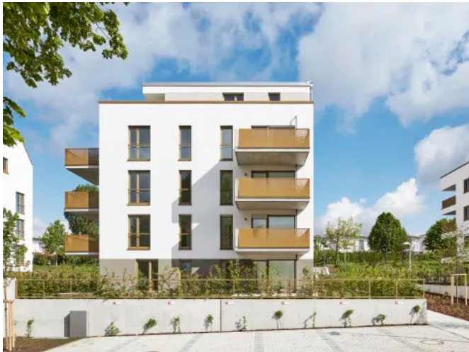
Wohnanlage Ludwigsburg, ARP ArchitektenPartnerschaft Stuttgart GbR (© Fotografie Dietmar Strauß)
