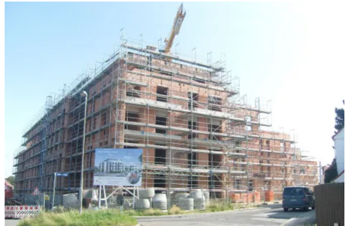
Für die ein- und zweischalige Ziegelbauweise bietet das Poroton Systemzubehör sichere und effiziente Lösungen für bis zu neun Geschosse. (© Wienerberger GmbH)
