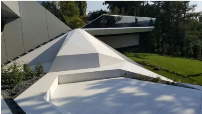
Wohngebäude Becker in Wien
