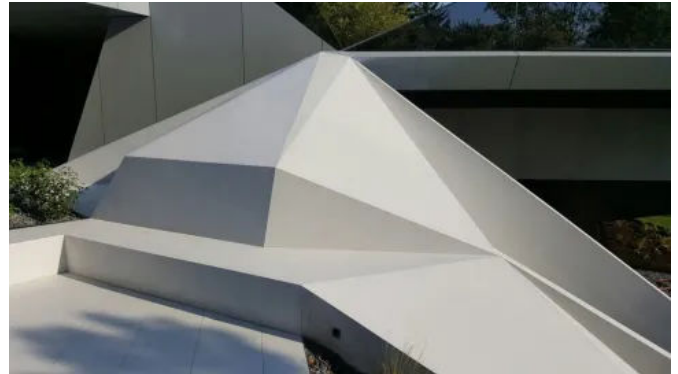
Wohngebäude Becker in Wien
