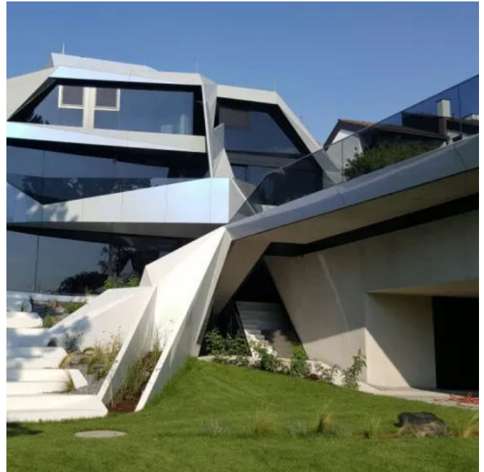
Wohngebäude Becker in Wien
