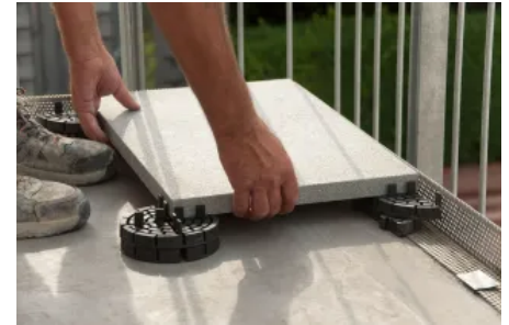
Die zu verlegenden Platten liegen immer mit einer Ecke auf einem Viertelstück eines PLATTENFIX Plattenlagers auf.
