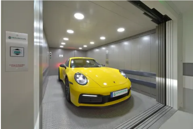
Jeder Fahrkorb ist mit Bedientableaus an den Längswänden, Beleuchtung und Stoßleisten ausgestattet.
