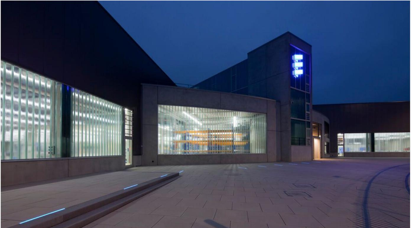
Glasbauelemente in verschiedenen Profil-Ausführungen zur sprossenlosen Verglasung. Die Normal- und Spezialprofile werden auch mit Längsdrahteinlage geliefert. Profilbauglas ist ein Alkali-Kalk-Glas, das wie Gussglas im Maschinenwalzverfahren, jedoch als U-Profil, hergestellt wird. Es ist durchscheinend, jedoch nicht durchsichtig, mit einer Ornamentierung auf der Profilaußenfläche und weist gussglaseigene Qualitätsmerkmale auf.
