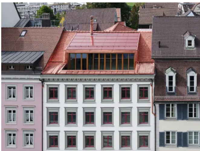
Raiffaisenbank Herisau, Schweiz | Architekt: Plan B Architekten, Goldach, Schweiz | (© Marcel Gantenbein, Schweiz)
