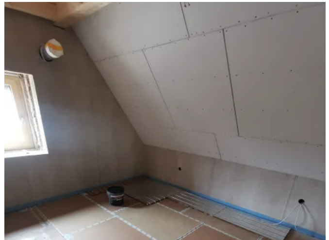
PhoneStar Platten als Schalldämmplatten an der Dachschräge
