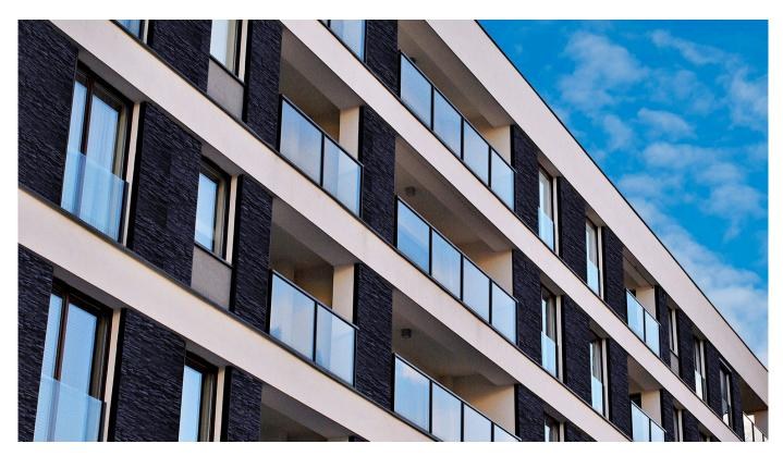
Q-railing bietet Pfostengeländersysteme für repräsentative Treppenhäuser, Balkone oder Atrien. Zur Auswahl stehen runde und eckige Komponenten aus Edelstahl oder Aluminium. Für die Füllung kann zwischen Drahtseilen, Stäben, Netzen, Lochblechen oder Glasscheiben in verschiedenen Ausführungen ausgewählt werden. Alle Geländersysteme lassen sich zudem schnell und ohne Schweißarbeiten montieren.
