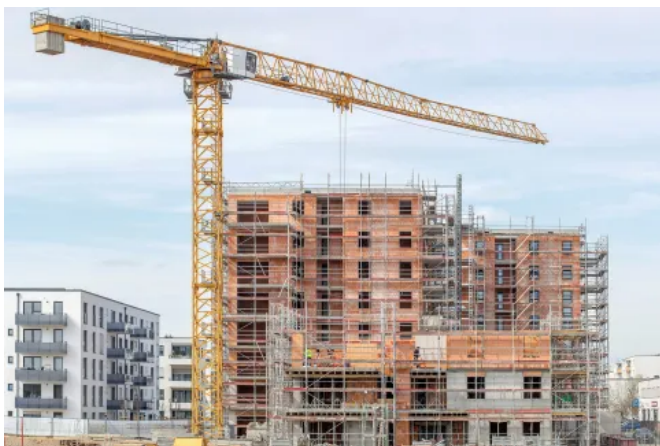
Die Objektziegel POROTON®-S7®, -S8® und -S9® von Schlagmann Poroton bieten statische Sicherheit für bis zu neun Stockwerke.
