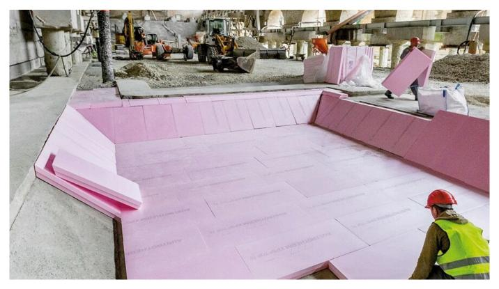
Eine Perimeterdämmung ist eine Wärmedämmung, die an den erdberührten Außenflächen eines Gebäudes angebracht wird – also an Kelleraußenwänden und unter der Bodenplatte. Sie gehört zu den wichtigsten Maßnahmen zur energetischen Optimierung von Gebäuden, insbesondere bei Neubauten oder Sanierungen.
