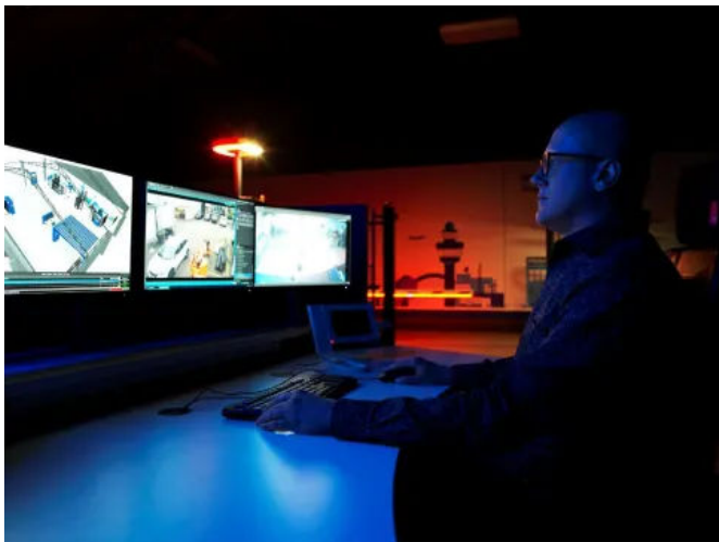
Kontrollraum — Detektionssystem GeoMic
