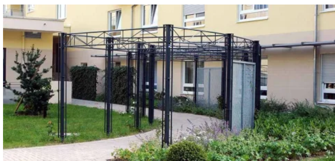
Pergola-Eingang — Tragkonstruktion Ambiente
