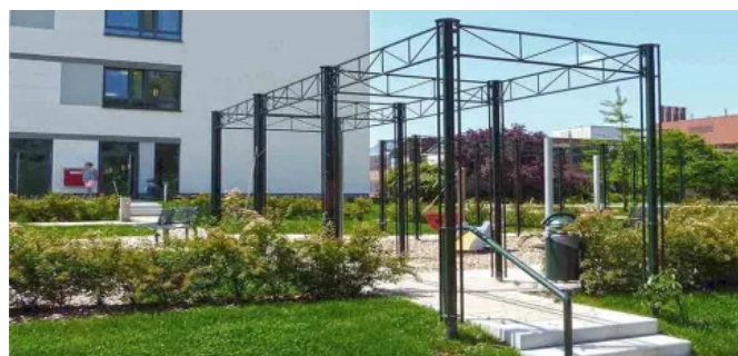
Pergola — Tragkonstruktion Ambiente
