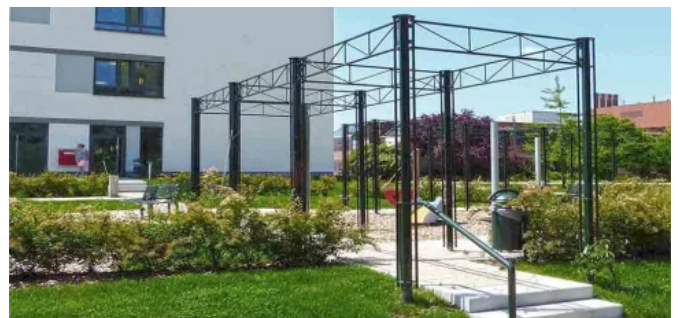
Pergola — Tragkonstruktion Ambiente
