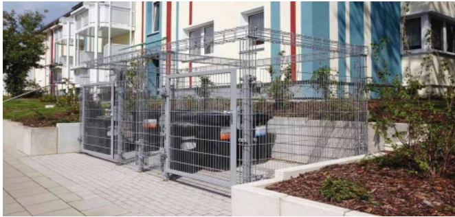
Müllplatz, Tragkonstruktion Drahtbalken mit Gittermatten
