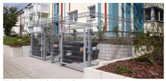
Müllplatz, Tragkonstruktion Drahtbalken mit Gittermatten
