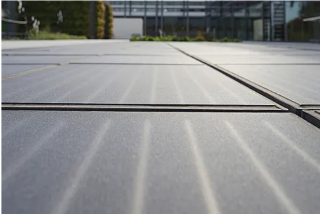
Das befahrbare Penter Platio PV-System wird analog zu herkömmlichem Pflasterklinker verlegt.
