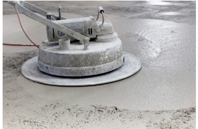
Einbau PCI Novoment® Z1
