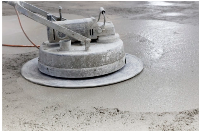
Einbau PCI Novoment® Z1
