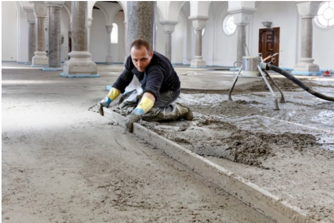
Einbau PCI Novoment® Z1
