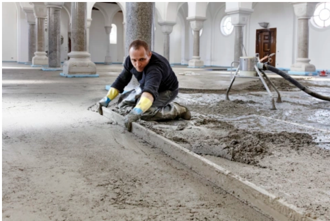
Einbau PCI Novoment® Z1
