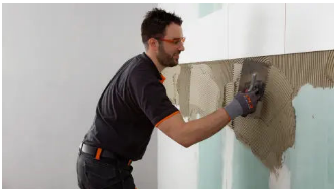
PCI Nanolight - der flexible Leichtmörtel, die Leichtfüllstoffe machen das Aufziehen sehr geschmeidig und leicht
