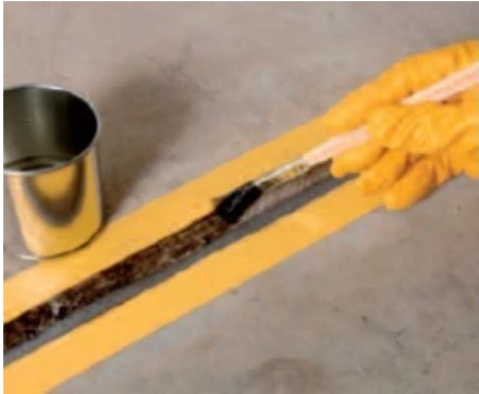
PCI Elastoprimer verbessert die Haftung von PCI-Fugendichtstoffen auf den angegebenen Untergründen
