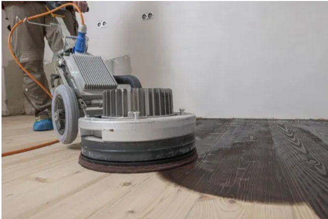
Die Ölgrundierung PALL-X 333 Color „Dark Brown“ wurde gleichmäßig auf der Fläche aufgetragen und nachpoliert.
