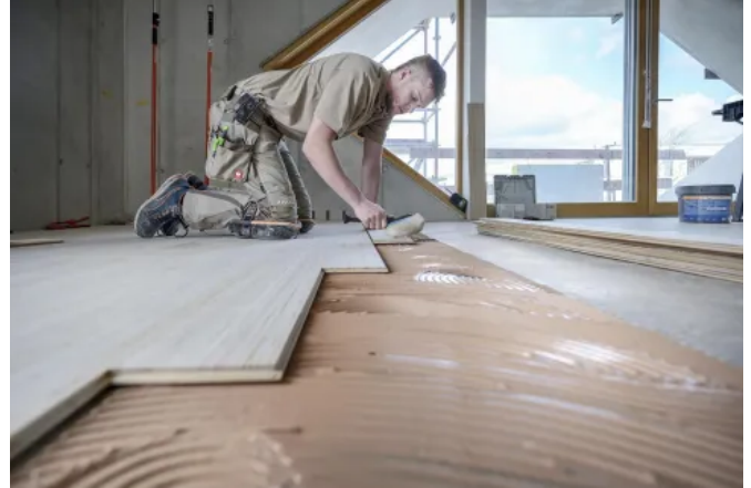
Für das präzise Verlegen des Birkenparketts kam der schubfeste und sehr emissionsarme Parkettklebstoff Uzin MK 250 zum Einsatz.
