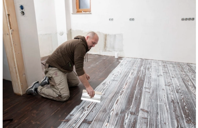
Der Farbspachtel PALL-X Color Effect setzt sich in der Holzstruktur ab und betont die natürlichen Maserungen.
