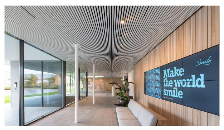
Die Klimadecke PareauLux ist in drei Ausführungen aus dem Luxalon®, HeartFelt® und Derako® Produktsortiment erhältlich: PareauLux 30BD, besteht aus gewalztem Aluminium mit Beschichtung, PareauLux Heartfelt® mit modularen, linearen Filzpaneelen aus thermogeformten PES-Vliesfasern und PareauLux Furnierholzraster. Sie können an spezifische Bedürfnisse und optische Kundenwünsche angepasst werden und sind in unterschiedlichen Farben und Paneelgrößen verfügbar.
