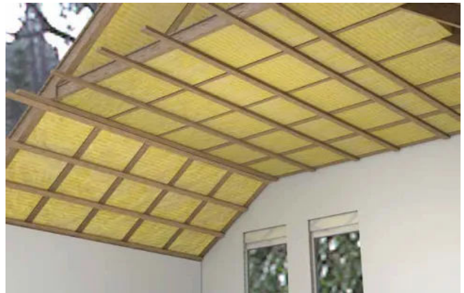
Dachschrägenbekleidungen können mit Unterkonstruktionen aus Holzlattung oder Metallprofilen ausgeführt werden.
