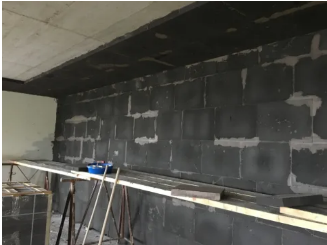
GEOMATERIALS Innendämmung unter der Decke und auf der Wand
