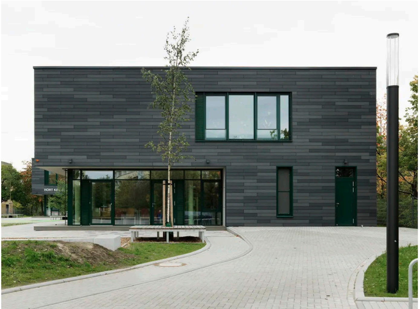
öko skin Fassadenlatten aus Glasfaserbeton am Kinderhort, Schwerin
