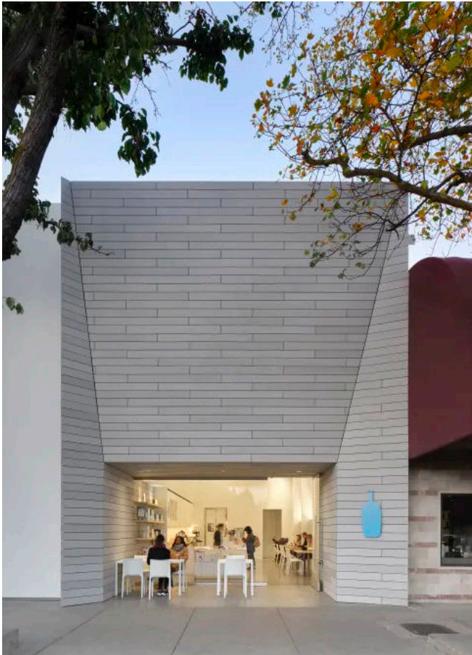
öko skin Fassadenlatten aus Glasfaserbeton am Blue Bottle Coffee, Stanford (© ADAM ROUSE PHOTOGRAPHY)
