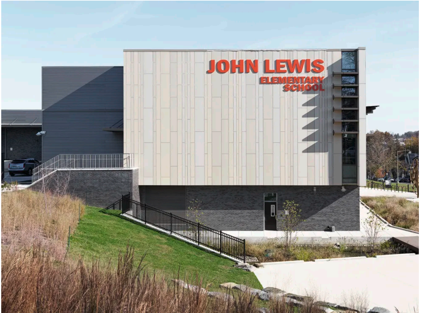
öko skin Fassadenlatten aus Glasfaserbeton an der John Lewis Elementary School, Washington DC
