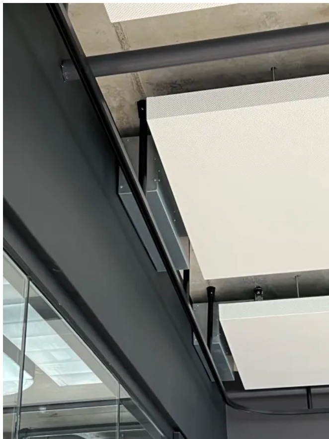
Profil HM-150 | abgehängtes Profil in Schwarz
