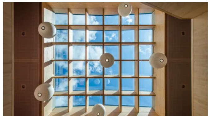
LAMILUX Glasdach PR60 Passivhaus Kita in Frankfurt-Harheim
