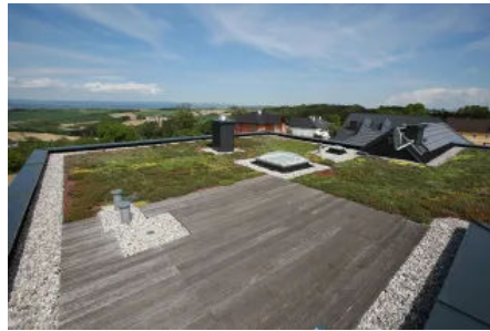
Flachdachbegrünung mit Terrassendeck
