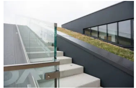
Dachbegrünung auf geneigter Dachfläche
