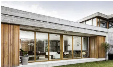
Turner Oak malt in Kombination mit rohem Sichtbeton sorgt für coole Eleganz.
