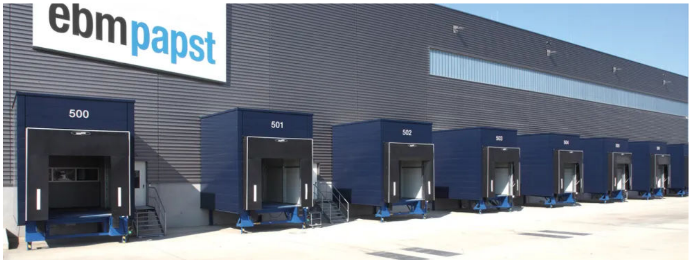
Versandzentrum ebmpapst Mulfingen GmbH & Co. KG
